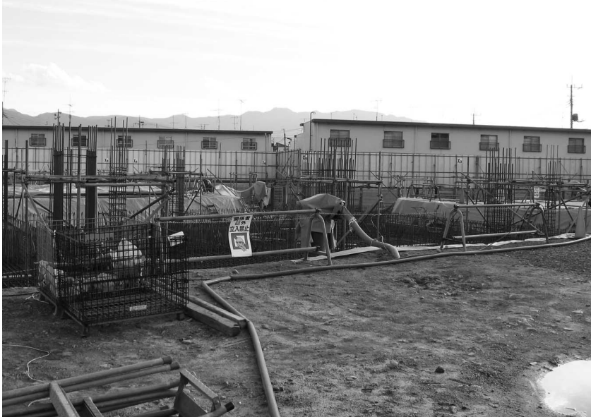
建設中の快適さを追求した新常永町営団地
