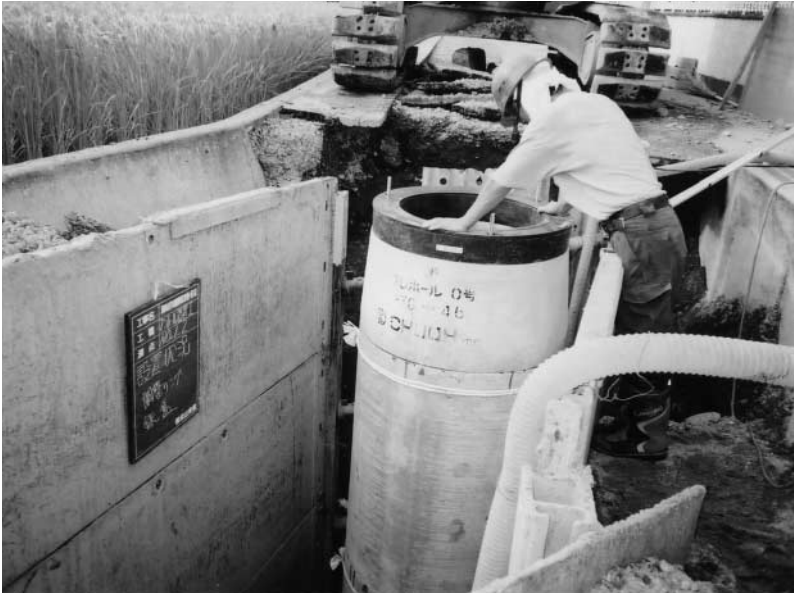
住みやすい昭和を目指して進む下水工事
