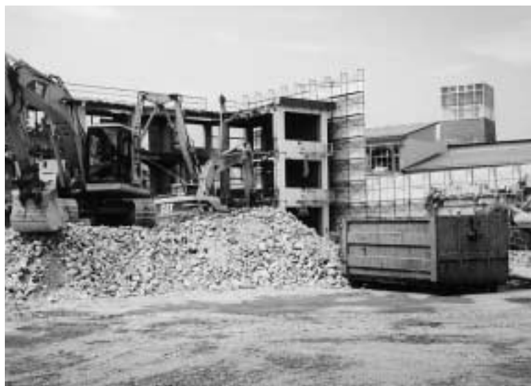
新しい校舎の横で解体工事が進む旧校舎
