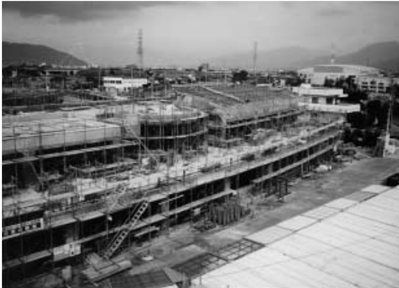
指名競争入札で行われた押原小学校改築工事（H15）
