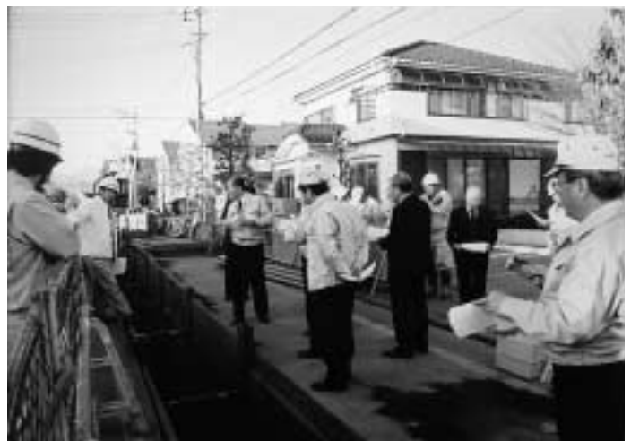
下水道工事箇所を視察する産業土木委員会
