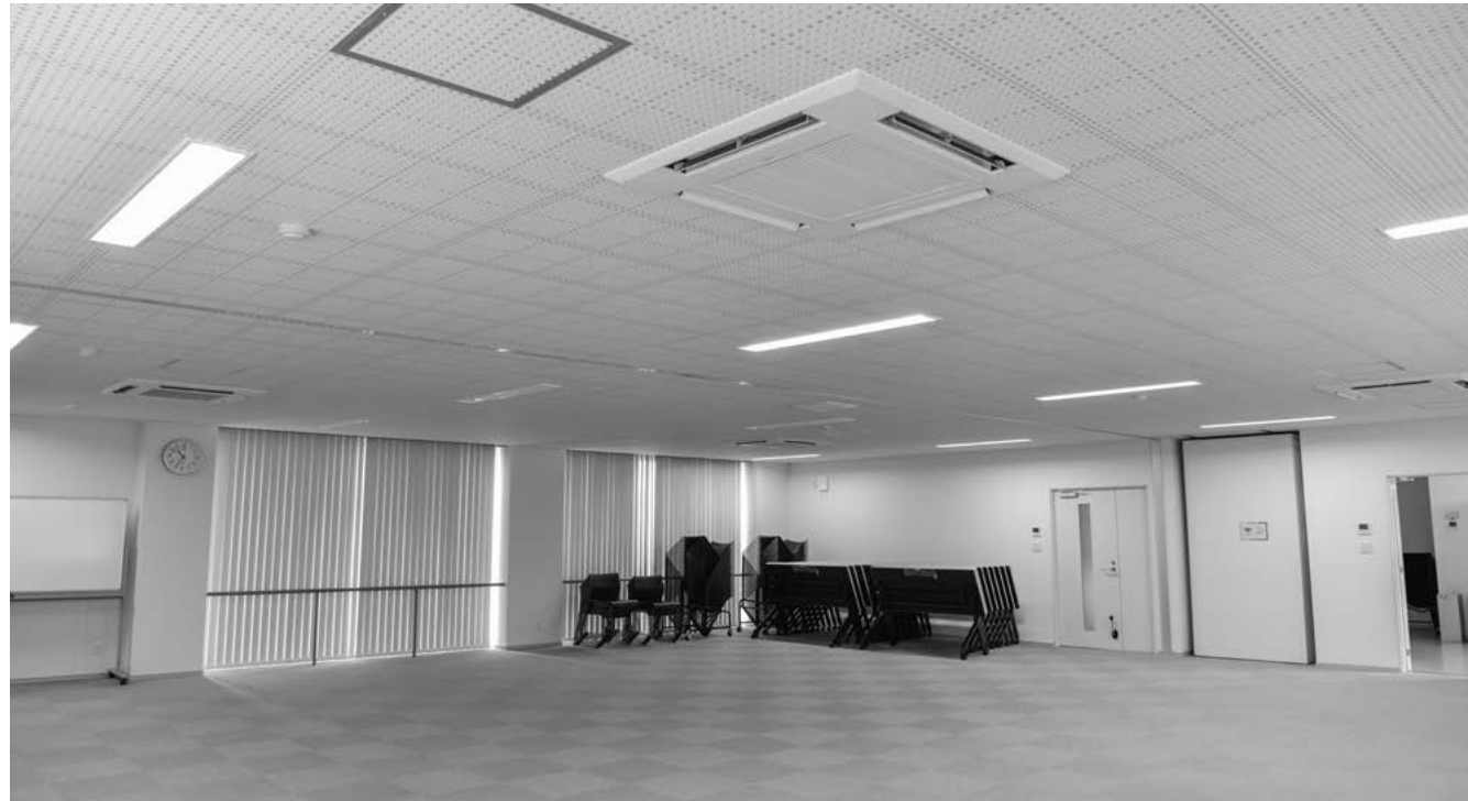
▲パーティションを収納すれば広いスペースを確保できます。
