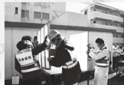
設置型給水タンクの 組み立ての様子
